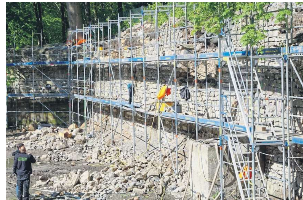
Umgestaltung Cheltenham-Park in Göttingen: Die mächtige Stützmauer am leergemauerten Schwächenteich im südlichen Stadtwall-Bereich wird aufwendig saniert.
